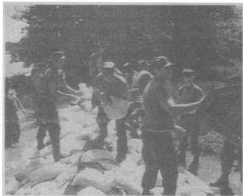
Рис. 3. Национальные гвардейцы США на строительстве дамбы для защиты от наводнений
